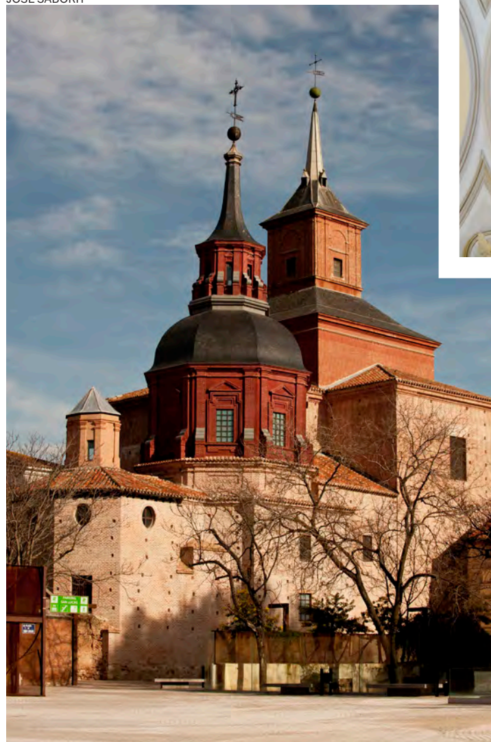
↑ Vista exterior de la capilla, en la iglesia de Santa María.
